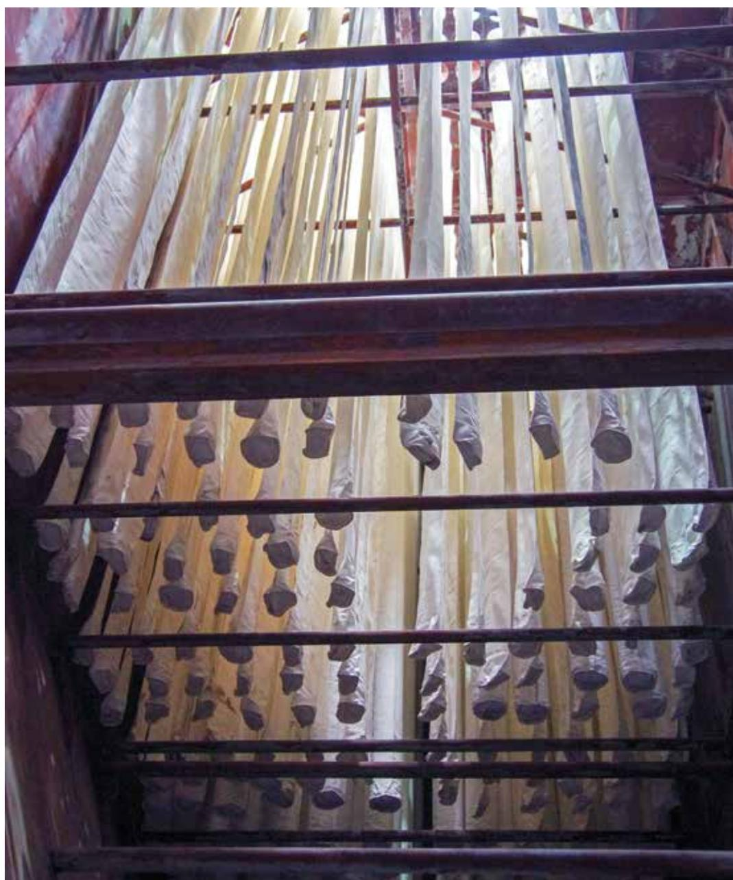
*Chaque ligne de valorisation énergétique est équipée de deux filtres à manches montés en série. Chacun contient entre 400 et 500 manches. Ces dernières permettent, associées à du charbon actif puis du bicarbonate de sodium, de capter les polluants et les particules contenus dans les fumées. Afin de compléter l'abattement des dioxines et furanes, le 2<sup>ème</sup> filtre de chaque ligne est équipé de manches à effet catalytique. Ce dispositif assure une épuration efficace des rejets.*
