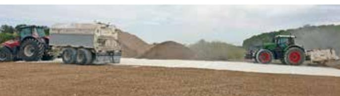
Le chantier de traitement des déchets inertes qui s'est déroulé de mai à août a été l'occasion de réaliser une partie des tests notamment le chaulage des fractions fines riches en argile. Le résultat est la production d'une grave recyclée chaulée insensible à l'eau qui, de ce fait, trouve plus facilement preneurs auprès des entreprises de travaux publics.
