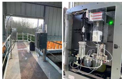
Un analyseur d'orthophosphate (phosphore minéral) mesure en continu la concentration en PPO43- sur les trois files du traitement tertiaire. Le régulateur ajuste ensuite, voire stoppe, la quantité de chlorure
