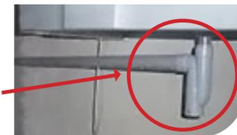
➔ **Les eaux de condensat provenant des pompes à chaleur** peuvent être rejetées sans distinction vers le réseau des eaux usées, des eaux pluviales ou en pleine terre.
