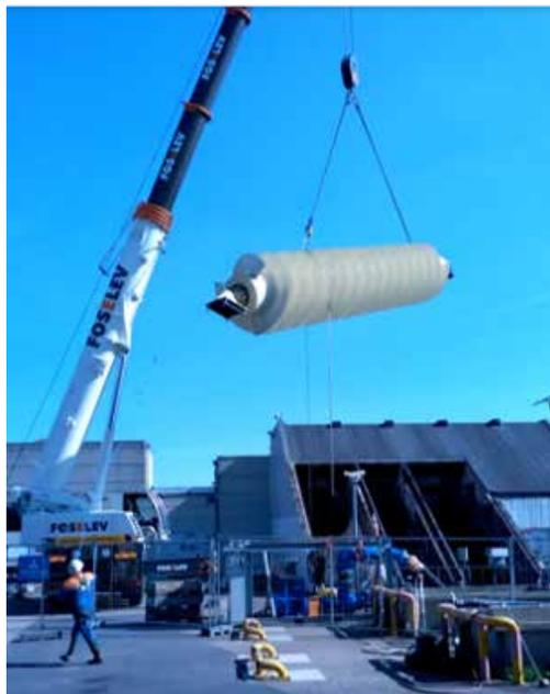
Les vis de relevage pèsent entre 6 et 13 tonnes et mesurent jusqu'à 13 mètres.
